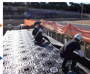
側面・上面シート敷設
