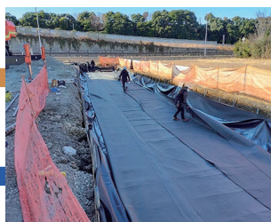
内面保護シート敷設
