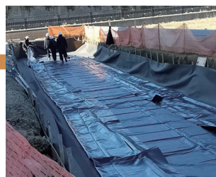
遮水シート敷設
