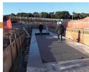
外面保護シート敷設
